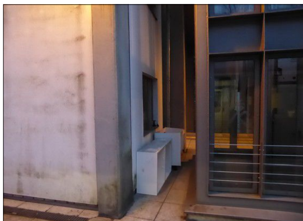
Abbildung 50: Neben dem Aufzugsschacht waren auf dem Bahnsteig in Aumühle ein alter Schrank und eine alte Spüle abgestellt.
