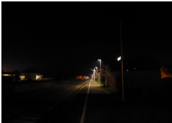
Abbildung 48: Schon der Ausfall eines einzelnen Lichtmasts der mit LED-Lichtköpfen ausgestatteten Beleuchtung in Nortorf führte zu einem dunklen Bereich auf dem Bahnsteig.
