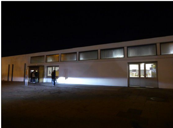
Abbildung 25: Durch fehlende Eingangsbeschilderung wirkt das Empfangsgebäude von Elmshorn trotz im Zuge des Vordachrückbaus erfolgter Fassadenanierung unscheinbar und weniger einladend.
