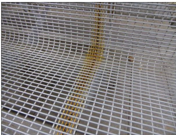
Abbildung 12: An einigen Bänken wie z. B. in Itzehoe (Foto) und Brokstedt ist Rostbildung zu beobachten. Die identischen Mängelbilder lassen auf einen Herstellungsfehler schließen.
