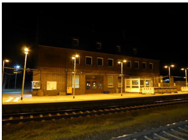
Abbildung 3: Die ursprünglich für den Oktober 2015 vorgesehene Wiederherstellung des Bahnsteigdaches in Glückstadt steht weiterhin aus. Die Fahrgäste finden am Bahnhof dazu leider keine aktuelle Information.
