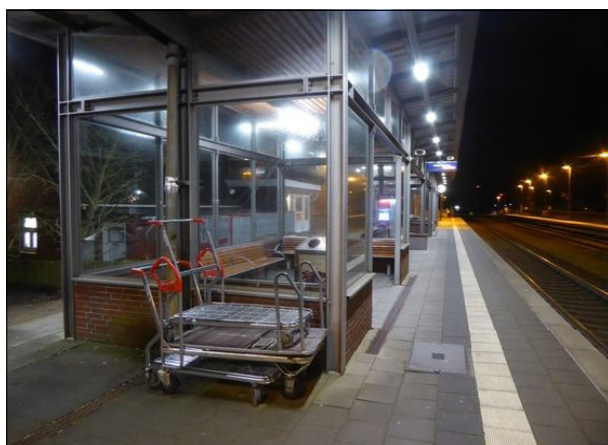
Abbildung 2: Zum wiederholten Mal waren in Klanxbüll Transportwagen auf dem Bahnsteig abgestellt. Dieses Mal waren sie jedoch nicht am Bahnsteigende sondern am beschädigten Fallrohr der Wartehalle angekettet.
