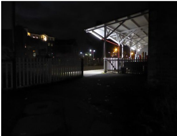
Abbildung 44: Der Zugang zu Gleis 1 in Flintbek ist unzureichend beleuchtet. Die Absackung im Asphalt ist dadurch nicht zu erkennen.
