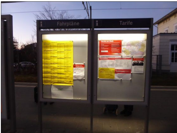
Abbildung 32: Die Vitrienen auf den Bahnsteigen in Ahrensburg wurden auf LED-Beleuchtungen umgerüstet. Diese leuchten die Aushangflächen gleichmäßig hell aus.
