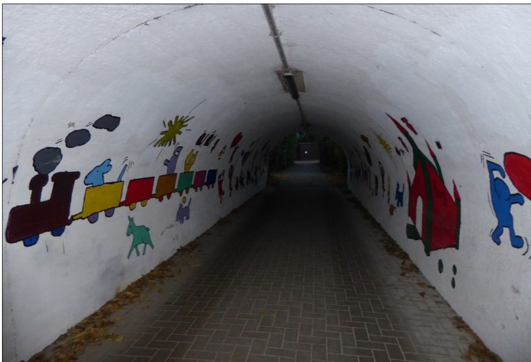
Burg (Dithm): Bahnhof an der Strecke Hamburg - Westerland. Der Tunnel, durch den der Bahnsteig an Gleis 2 erreicht wird, war unbeleuchtet.
